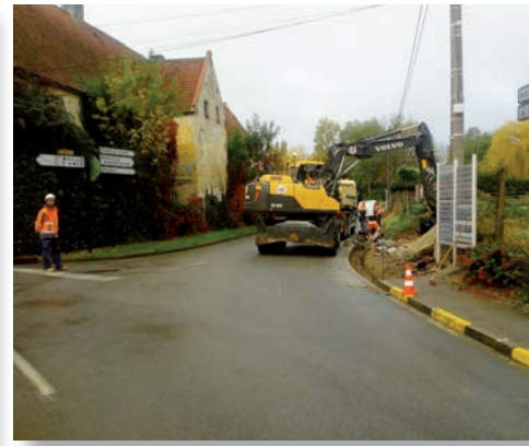
Aménagement du trottoir rue des Ecoles
