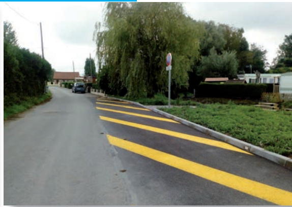
Aire de croisement et zone de pompage défense incendie, impasse du Marais
