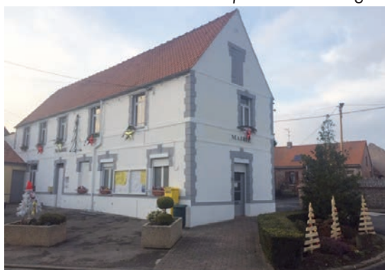
Rénovation peinture de la mairie
