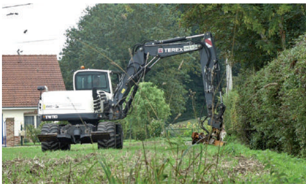
Curage des fossés collecteurs Wateringues (de la rue May jusqu'à son évacuation à la Houlle)
