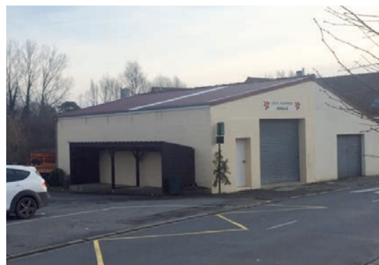
Réfection de la toiture de l'atelier municipal
